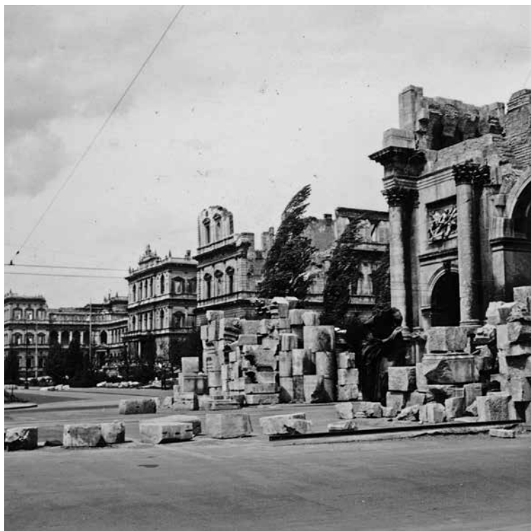
Bayern nach dem Krieg II: Aufräumarbeiten am beschädigten Siegestor.
