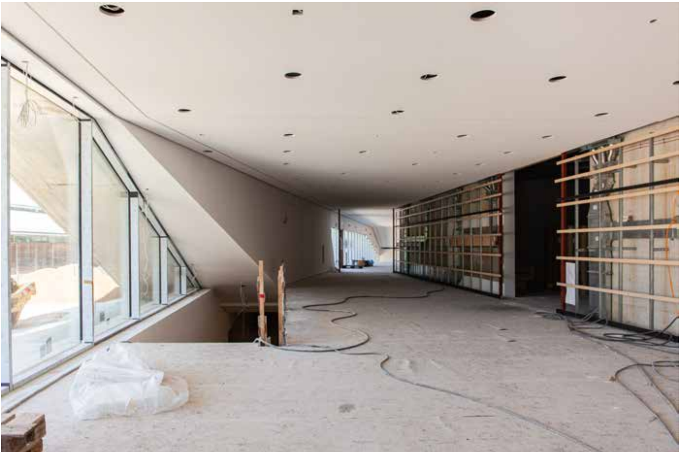
So sah es im August 2021 im Inneren des neuen Erweiterungsbaus aus.
