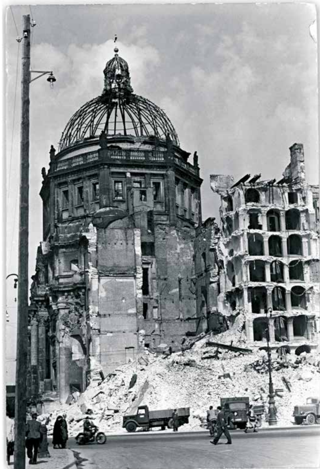
Abriss der Ruine des im Zweiten Weltkrieg zerstörten Berliner Stadtschlusses. Für dessen Wiedererrichtung hat auch der Bankier Ehrhardt Bödecker gespendet. Sein Geschichtsverständnis war Gegenstand eines IfZ-Gutachtens für die Stiftung Humboldt Forum.
