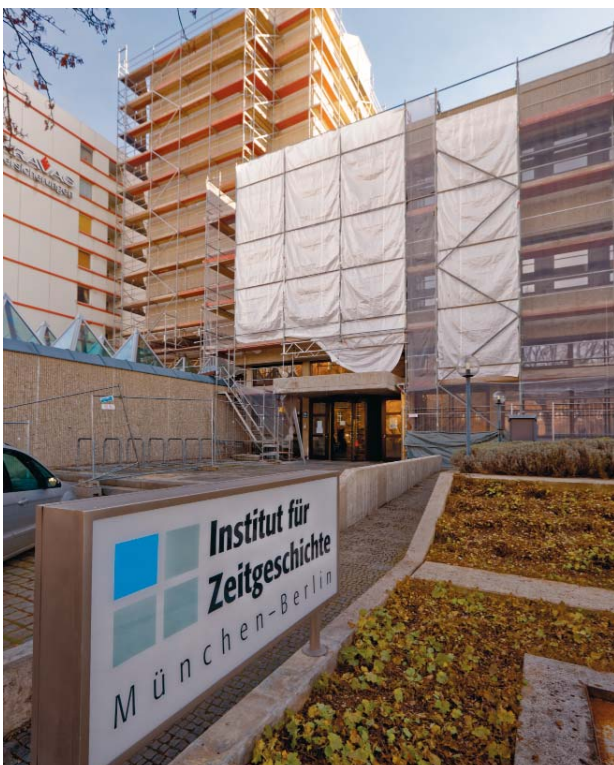
Wegen Sanierungsarbeiten an der Hausfassade musste das IfZ vollständig ingerüstet werden.
