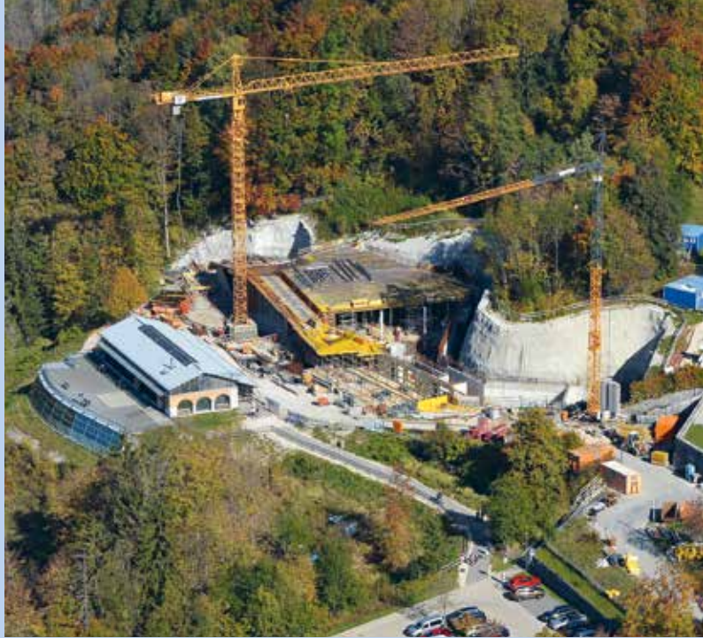
Die Baustelle für das neue Doku-Gebäude aus der Vogelperspektive.
