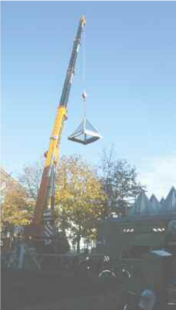
Eine der neuen Glaspysamiden wird auf das Dach des Lesesaals abgesenkt
